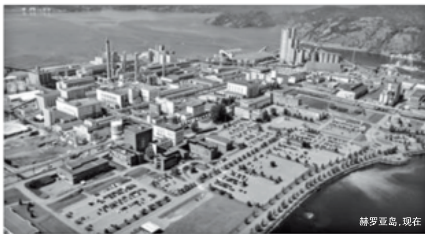
图2 挪威波什格伦市赫罗亚岛上的亚拉工厂(前身是挪威海德鲁公司)多年来废气排放的情况
